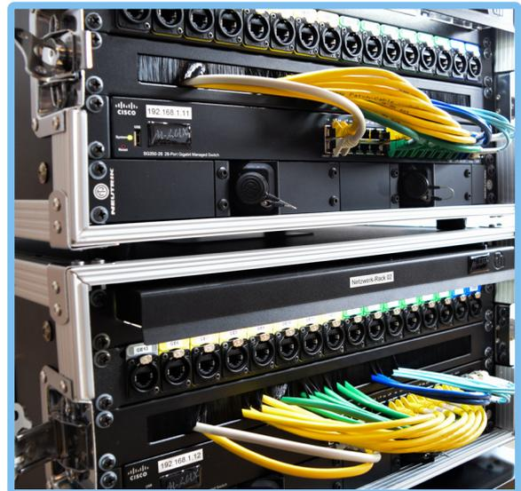
Die Backbone-Verbindung zwischen den Racks erfolgt entweder über Glasfaserkabel mit Neutrik opticalCON Duo bzw. Quad Steckern oder CAT-Kabeln.
